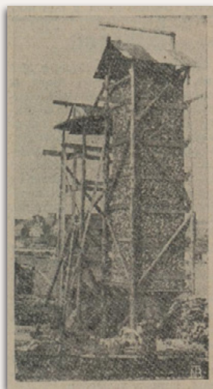
Et tårn eller silo for lufttørring av knott, ikke i Moss, men trolig i Sandnes. (Moss Avis 8.5.1944).
